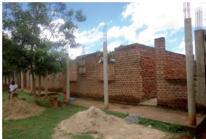
Aula en construcció
